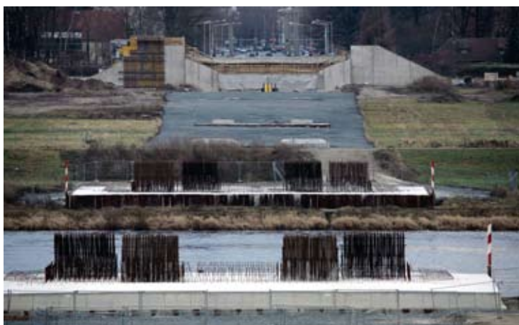
Brücke da, Welterbetitel weg
