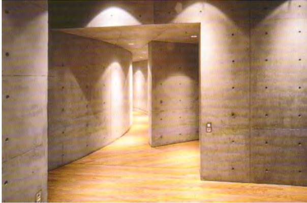
**Sichtbeton** ist Beton, der nicht verputzt oder verblendet wird. Er wird immer öfter im Außenbereich eingesetzt. Aber auch in Innenräumen kommt Sichtbeton zur Anwendung, wie dieses Beispiel zeigt. Sichtbeton wird für Autobahnbrückenpfeiler genauso verwendet wie für Gebäude.
